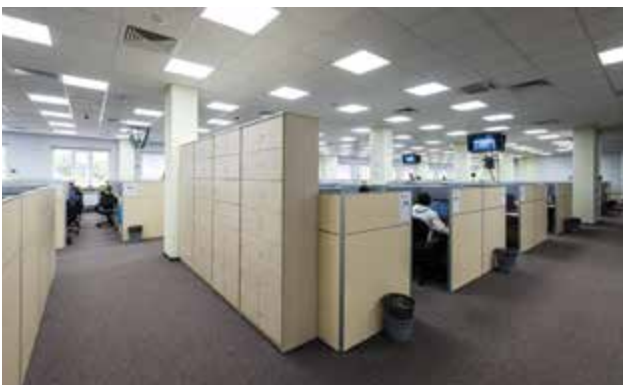
Реализованный проект по переоборудованию офиса Тинькофф. Светильники V-01-071-036-4100K
