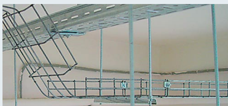
■ Пример монтажа кабельной трассы
