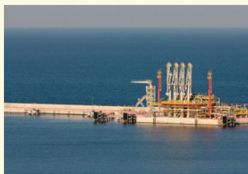
Terminal LNG (gazoport) Świnoujście
