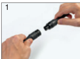
1 Соедините греющий кабель с кабелем питания
