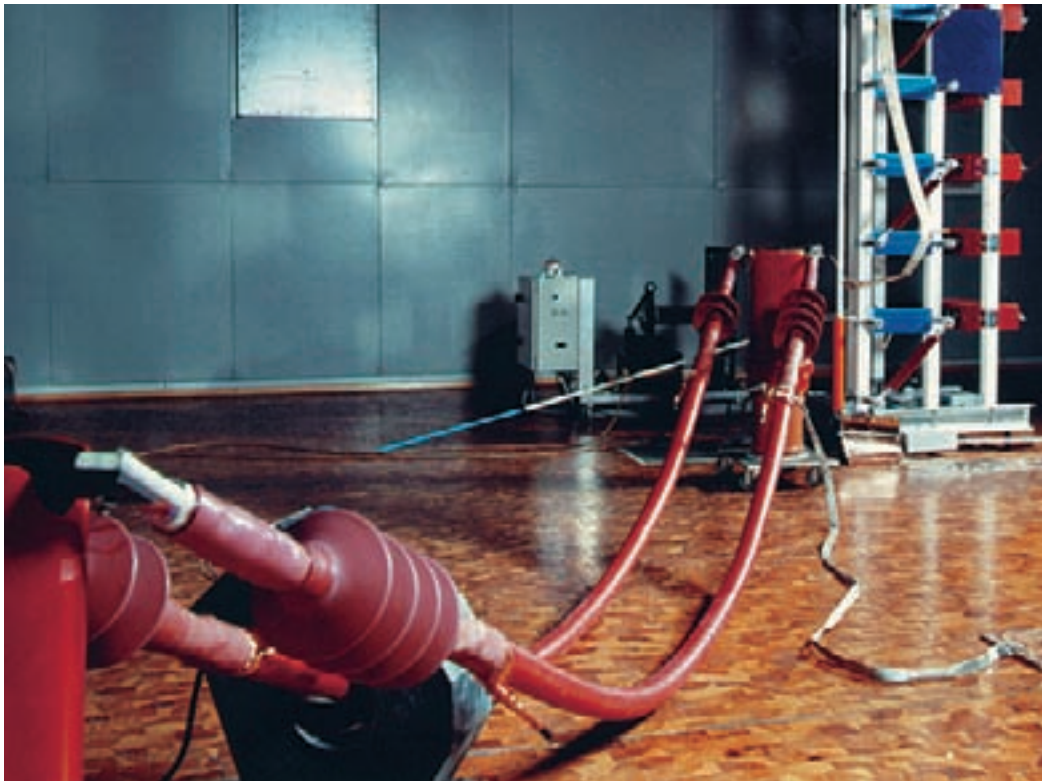
Prüflabor Tyco Electronics Ottobrunn
