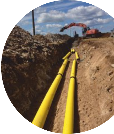
Dubultsienu 250 un 315 mm kabeļu aizsargcauruļu uzstādīšana
