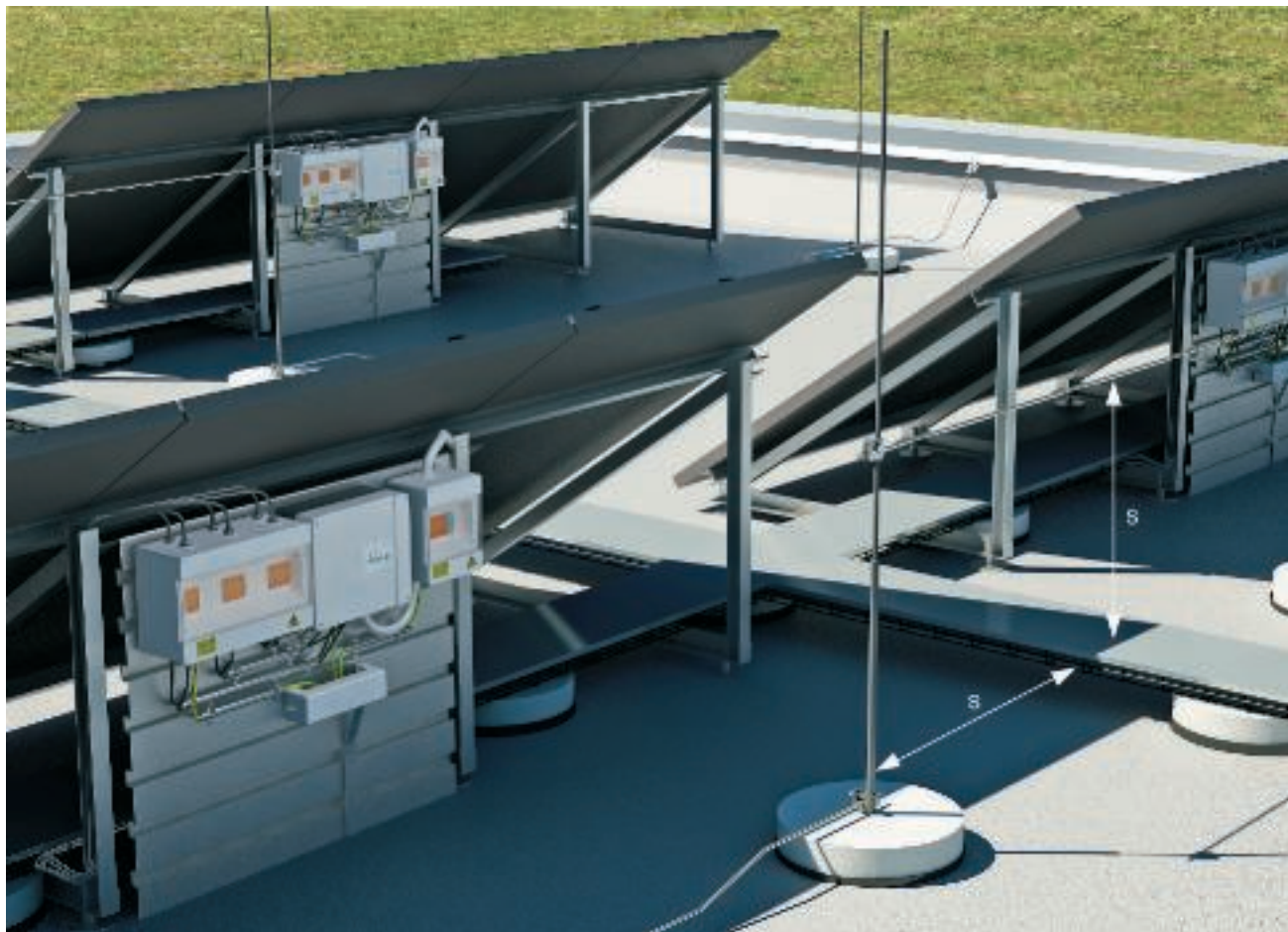
5. attēls: Atstarpes attālums (s) starp kabeļu kanālu un zibensizlādes uztveršanas iekārtu
